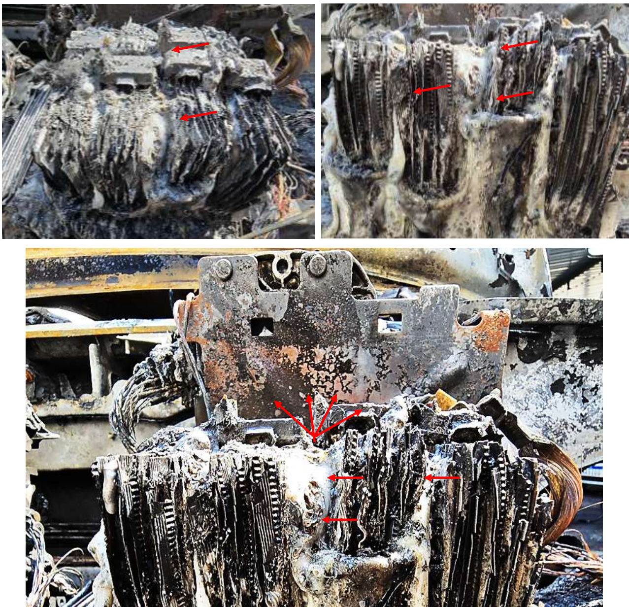
Figura 48 a 50 – Setas vermelhas mostram bateria, apresentando danos severos por queima, sendo constatado derretimento entre os vasos/células. Tal condição é compatível com a ocorrência de reação exotérmica interna, promovendo processo de
